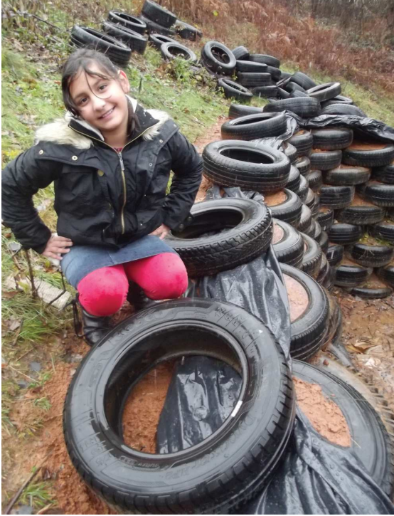
Zemljobrod u izgradnji kod Karlovca
